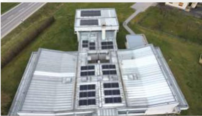
Auf dem Dach der Volksschule in Strem wurde im Jänner eine Photovoltaikanlage mit einer Leistung von 20 kWp installiert. Um den Schulbetrieb auch bei Stromausfällen aufrecht erhalten zu können, wurde zudem eine Notstromversorgung inkl. eines Speichers mit einer Größe von 10 kWh eingebaut. Durchgeführt wurden die Arbeiten von der Firma SOLAH GmbH aus Eisenstadt. Seit 28. Februar ist die Anlage nun im Betrieb und versorgt unsere Volksschule mit grünem Strom.
